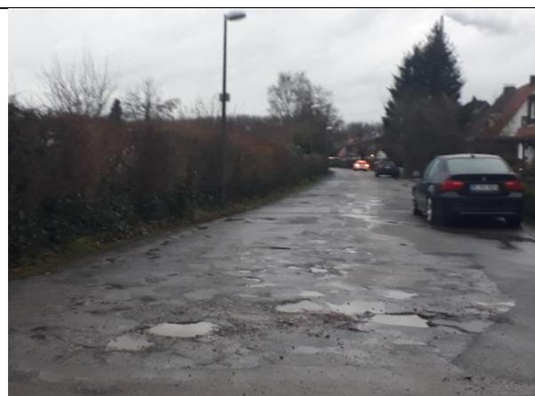
Durch immer weitere Risse auf den Straßen gelangt Flüssigkeit unter die ohnehin schon marode Fahrbahndecke. Gefriert das Wasser, dehnt es sich aus und beschädigt den Asphalt.
